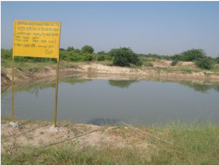
खेत तलाई (टांका) निर्माण
